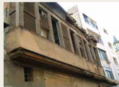
Construction vieillissante à Qanawat
