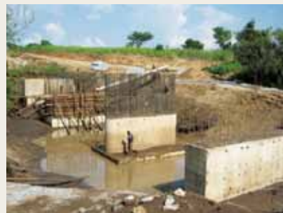
Chantier de construction du pont reliant Otwee à Anaka
