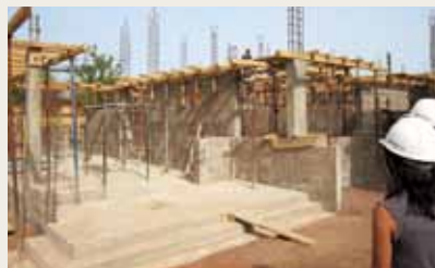
Le chantier du centre de santé avance.
