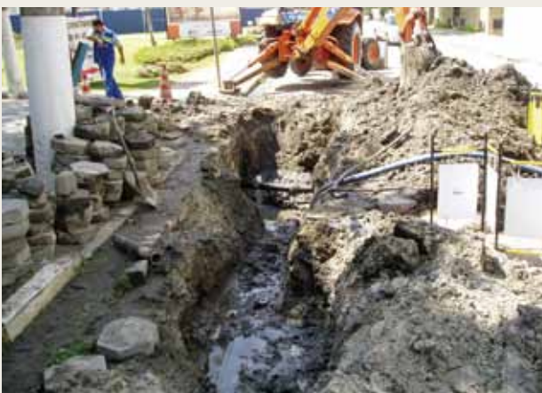
Réparation des fuites d'eau
