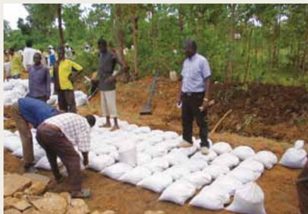
Un groupe d'agriculteurs restaure une route du village à l'aide de sacs de sable. Cette activité réalisée en commun a contribué à resserrer les liens du groupe.
