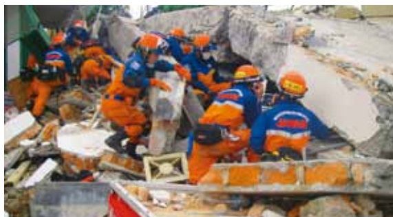
Activités de recherche dans un bâtiment effondré
