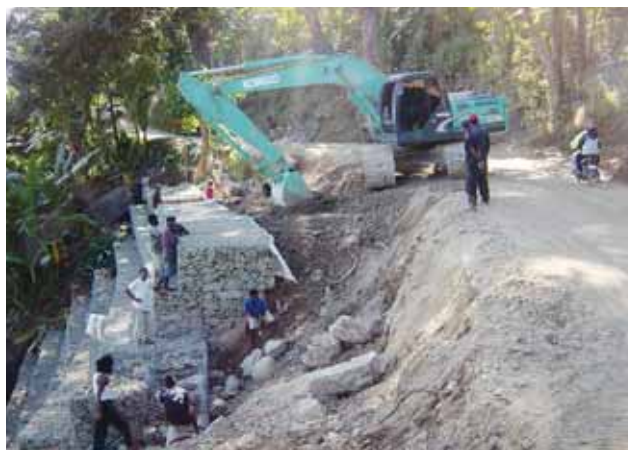
Les pluies torrentielles durant la saison tropicale abiment souvent les routes et provoquent des blocages (la photo est prise au cours du travail de rénovation du gouvernement). La JICA soutient le renforcement des capacités pour le travail de maintenance des routes (Timor-Est).
