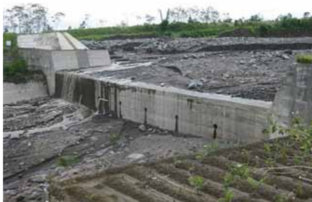
Le barrage Sabo, construit avec la coopération de la JICA, empêche les coulées de débris après l'éruption du mont Merapi (Indonésie).
