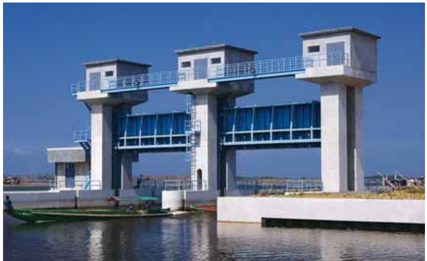
Un barrage anti-inondation (photo) et des canalisations financés par des prêts d'APD équipent la zone de Kamanava, située sur une plaine ouverte fréquemment inondée, dans le Grand Manille, aux Philippines.
