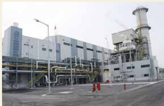
La centrale de cogénération électrique à cycle combiné d'Erevan une fois la construction achevée
