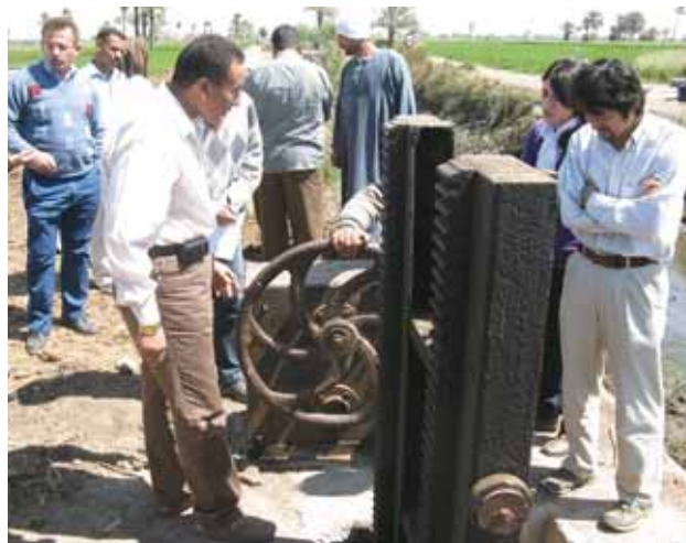
Travaux de réparation d'une conduite d'eau sur un site pilote pris en charge conjointement avec une association pour l'irrigation (plan pour l'amélioration de la gestion de l'eau, phase II en Égypte).
