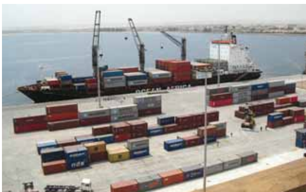
Le port de Namibe, en Angola, a été remis en état grâce à des dons.
