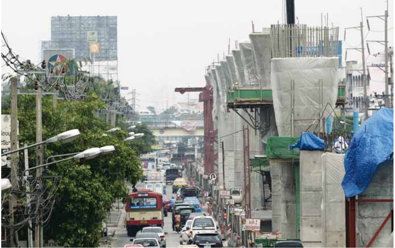
À Bangkok, capitale de la Thaïlande, la ligne Violette du métro, qui relie Bangkok à la province voisine de Nonthaburi, est construite avec l'aide de prêts d'APD.
