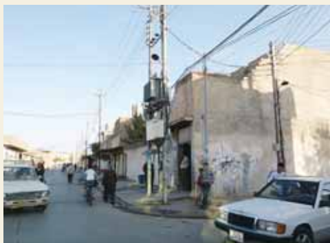
Équipement pour la distribution d'électricité financé par un prêt d'APD (Erbil, nord de l'Irak (Kurdistan))
