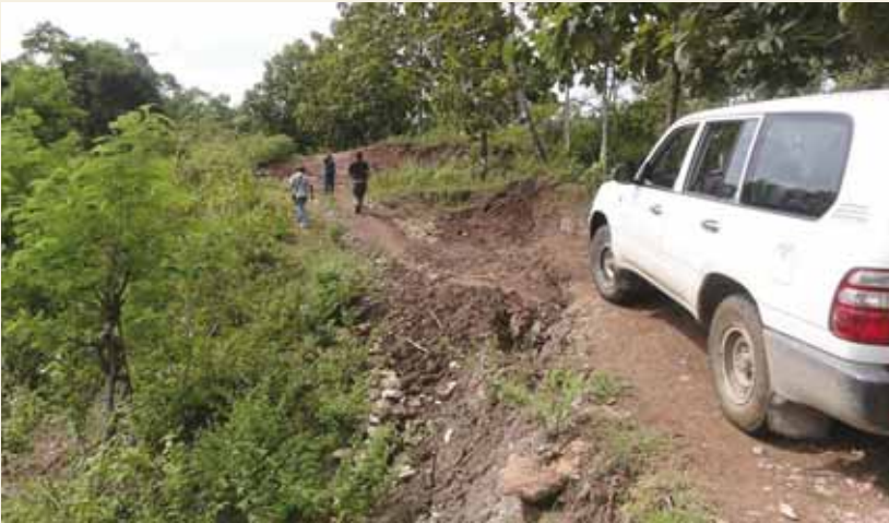
La déformation de la route associée à l'effet des pluies torrentielles rend son utilisation particulièrement difficile.
