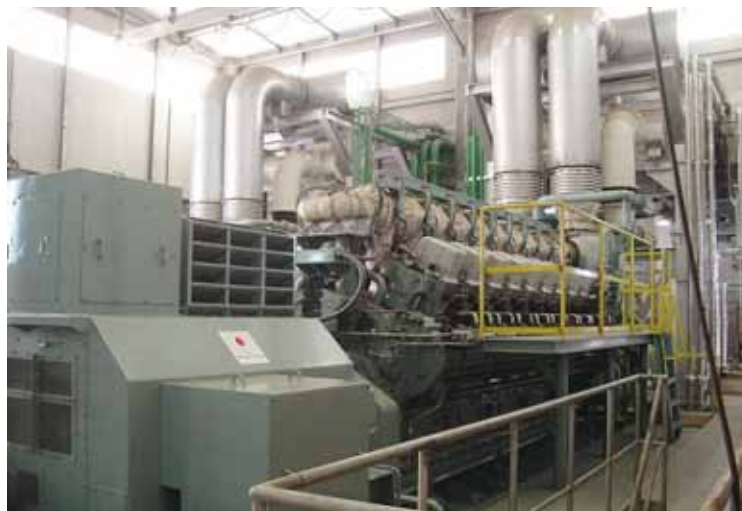
Générateur diesel offert à titre de don pour soutenir la reconstruction économique de la Sierra Leone, où la guerre civile s'est achevée en 2002. Depuis 2010, année de mise en service du générateur, la JICA apporte une coopération pour améliorer les capacités de la Sierra Leone à exploiter et gérer les installations électriques.
