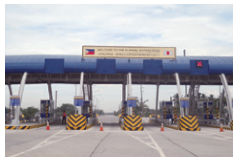
Les grands axes routiers permettront aux voyageurs et au fret de circuler entre Manille et les zones environnantes.
