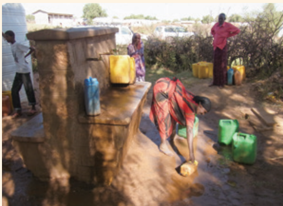
Installation d'approvisionnement en eau à Gode, dans la région Somali d'Éthiopie.
