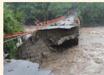
Les écoulements des pluies torrentielles ont emporté une partie du côté aval du pont, qui a été fermé par les habitants des environs.
