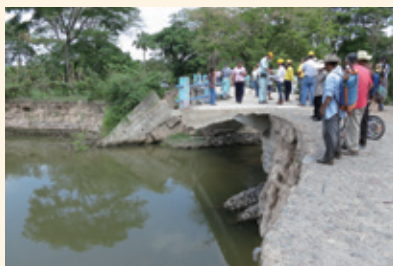
Le pont de La Zorra, dans la province de La Paz, au sud du Salvador, a été endommagé par les pluies dues à une dépression tropicale en octobre 2011.
