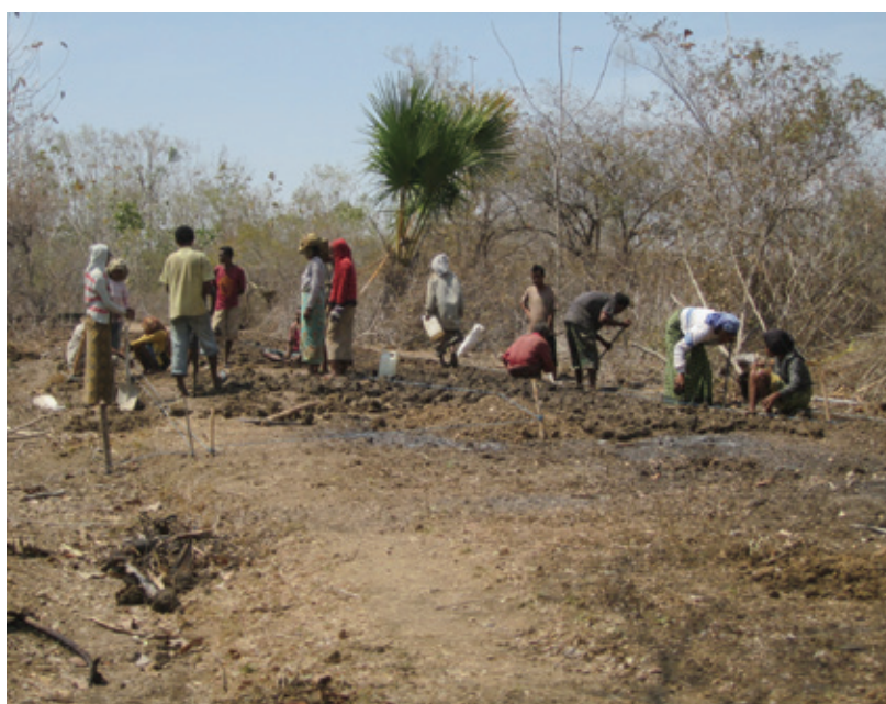
Des habitants participent à la construction de routes locales. (Timor-Est)
