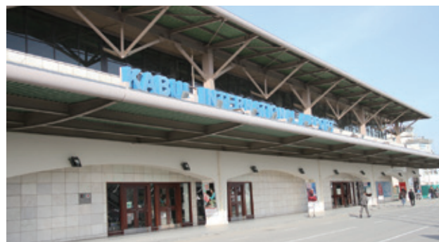
Un don a été octroyé pour la construction du terminal de l'aéroport international de Kaboul, la capitale de l'Afghanistan. L'aéroport constitue à présent un lien vital entre l'Afghanistan et le monde, sa fréquentation ayant bondi de 300 000 passagers avant le projet à plus de 900 000 voyageurs aujourd'hui. (Photo : Sayad Jan Sabawoon)
