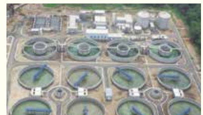
L'usine de traitement des eaux usées
