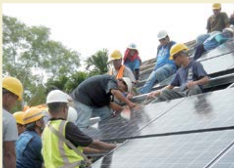
Installations de panneaux solaires en Micronésie.
