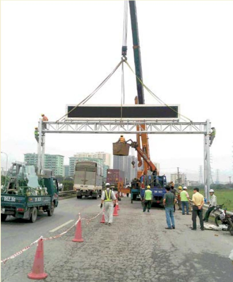
Installation sur une autoroute de Hanoï, au Vietnam, d'un système de contrôle de la circulation financé par un don.
