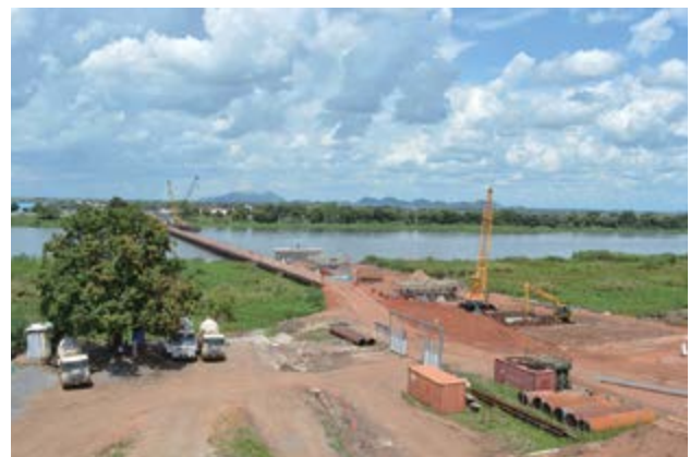
Un nouveau pont en construction sur le Nil. Au Soudan du Sud, la reprise complète de la coopération a permis de poursuivre en mars 2015 la construction du pont sur le Nil (Freedom Bridge), symbole de la consolidation de la paix. (Crédit photo : Dai Nippon Construction)
