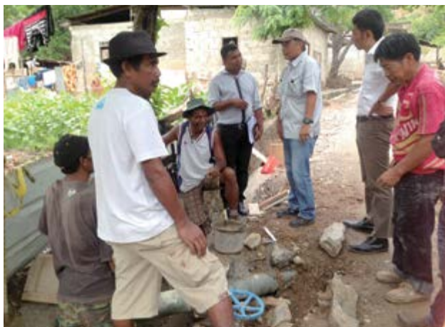
Un conseiller en approvisionnement en eau répare une canalisation détériorée à Dili, au Timor-Est.
