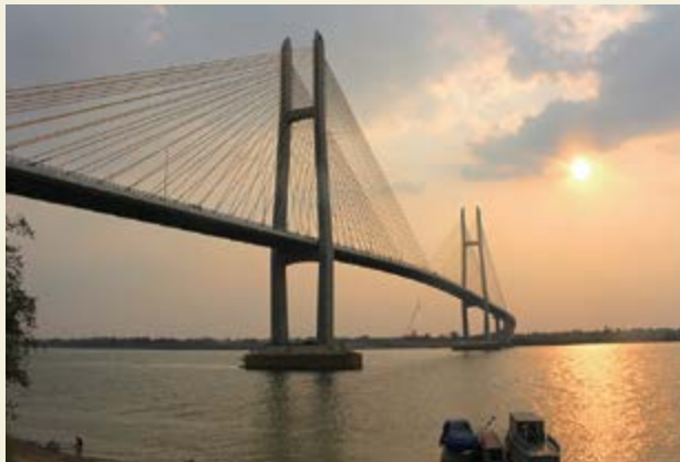
Le pont Tsubasa vu de la rive est du fleuve Mékong. La grue utilisée pour la construction a été retirée juste avant l'inauguration. (Photographie mars 2015)
