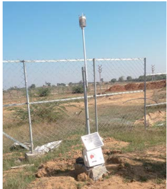
Une station météorologique automatique (SMA) installée en Inde dans le cadre du projet de recherche de réseau d'informations pour l'atténuation et le rétablissement face aux catastrophes naturelles.
