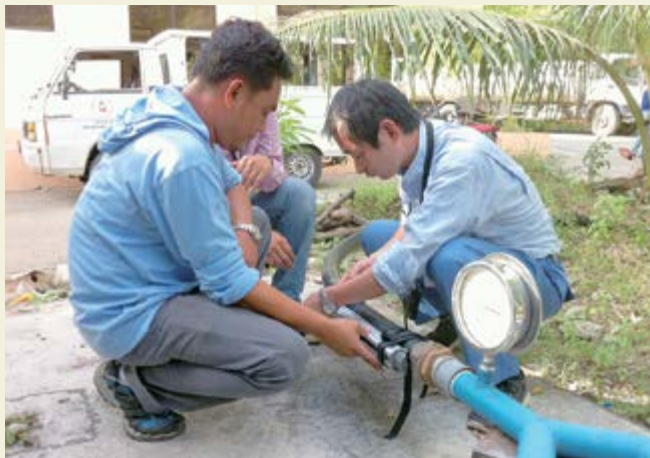
Un membre de la mission de Yokohama Water mesure la vitesse d'écoulement en utilisant un débitmètre à ultrasons à Cebu.
