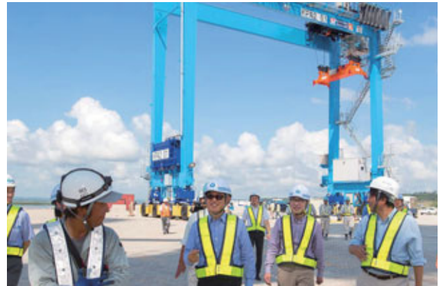
Dans le port kényan de Mombasa, M. Kitaoka a inspecté un nouveau terminal dont la construction, financée par un prêt japonais d'APD, était sur le point de s'achever.
