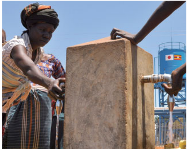
Des résidents du nord de l'Ouganda utilisent les équipements d'approvisionnement en eau installés grâce à des dons japonais.
