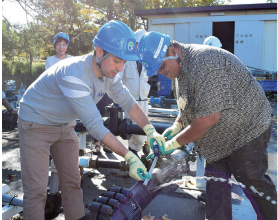
Des participants apprennent une technique de réparation des fuites d'eau dans un centre de formation de Hamamatsu, dans la préfecture de Shizuoka : programme de co-crédation des connaissances (par région et en groupe) – gestion de l'eau non comptabilisée (contrôle des fuites).
