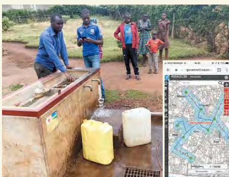
Des agents de maintenance vérifient une installation d’approvisionnement en eau ; ils peuvent consulter des cartes SIG sur un smartphone.
