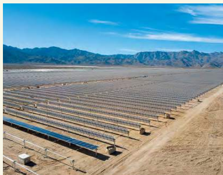
Mexique : Installations pour la production d'énergie solaire (Photo : IEnova)
