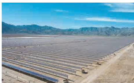
La JICA a signé un accord de prêt avec Infraestructura Energética Nova, S.A.B. de C.V. (IEnova), une entreprise mexicaine du secteur de l'énergie, afin de développer ses activités de production d'énergie solaire à grande échelle et de contribuer aux efforts de lutte contre le changement climatique. (Mexique) Photo : Avec l'aimable autorisation d'IEnova
