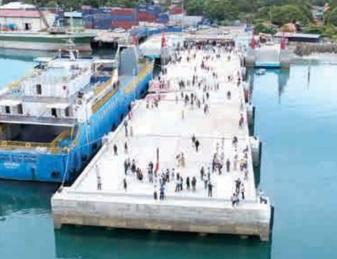
À Dili, dans le seul port international du pays, le terminal de ferry existant a été déplacé et agrandi, contribuant ainsi à l'expansion d'un transport maritime sûr et efficace. (Timor-Est)
