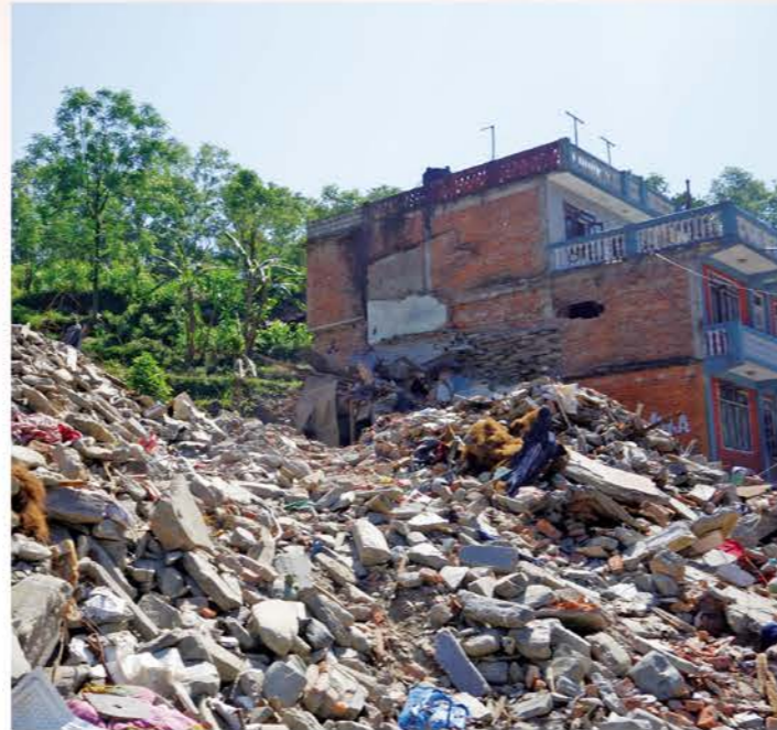
Exemple de constructions ayant résisté au séisme grâce à leur armature, quoique insuffisante, de barres et de traverses métalliques (à l'arrière-plan). Les bâtiments privés ne disposant d'aucun dispositif antisismique se sont effondrés (au premier plan). (Népal, mai 2015)
