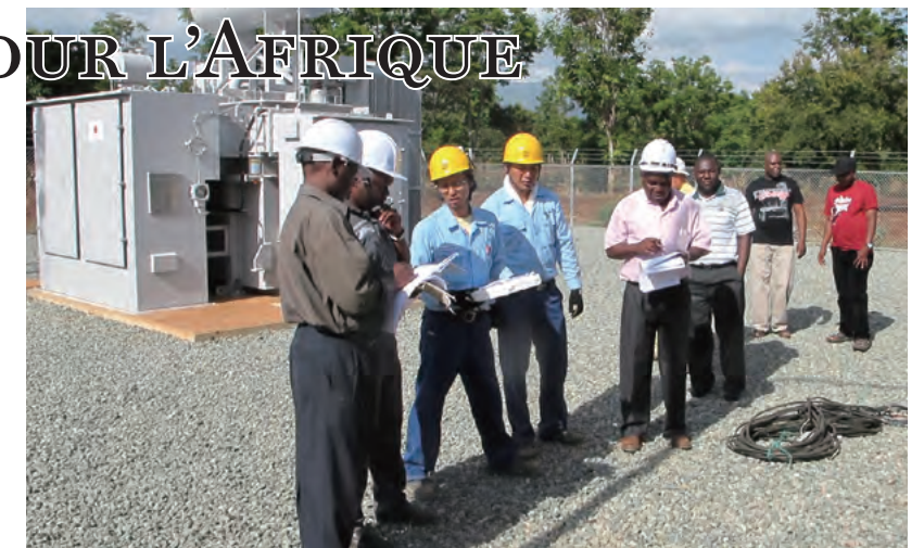
Experts japonais et tanzaniens effectuent une inspection finale avant l'inauguration de la nouvelle sous-station électrique du Kilimandjaro.
