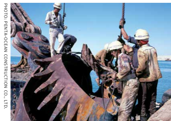
Des ouvriers remplacent un outil de coupe de 3 mètres de diamètre relié à une élinde.
