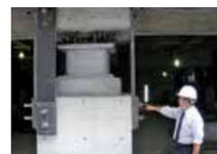
Un dispositif d'isolation parasismique fixé à un pylône sous un bâtiment municipal d'Arakawa.
