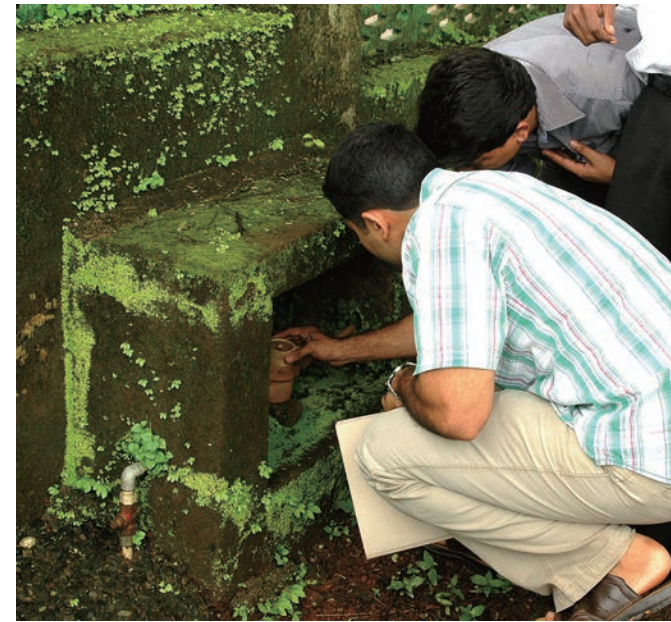
Même si la plupart des logements sont équipés de compteurs d'eau, les dysfonctionnements sont fréquents (à gauche). Les fuites comme celle-ci au niveau des joints causent d'importantes pertes en eau.
