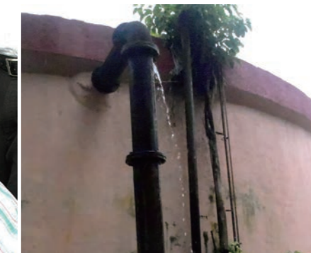
Même si la plupart des logements sont équipés de compteurs d'eau, les dysfonctionnements sont fréquents (à gauche). Les fuites comme celle-ci au niveau des joints causent d'importantes pertes en eau.
