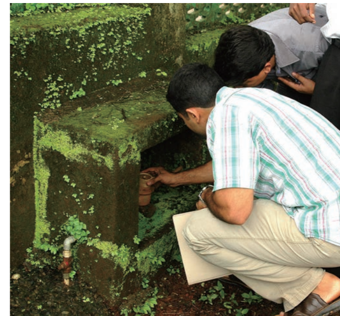
Même si la plupart des logements sont équipés de compteurs d'eau, les dysfonctionnements sont fréquents (à gauche). Les fuites comme celle-ci au niveau des joints causent d'importantes pertes en eau.
