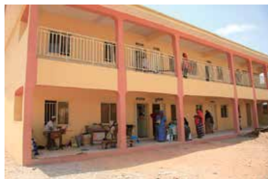
Le CDF de Paikoro, dans l'État de Niger, tout juste reconstruit.
