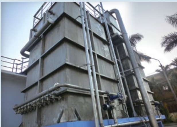
L'usine de traitement des eaux de Vinh Bao dans la ville de Hai Phong (construite en 2013)
