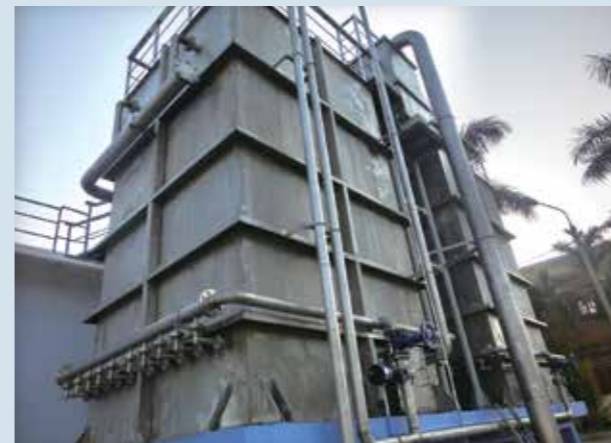
L'usine de traitement des eaux de Vinh Bao dans la ville de Hai Phong (construite en 2013)
