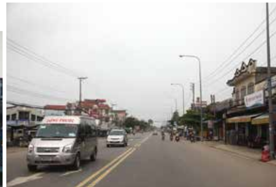
Les routes du Vietnam sont bien entretenues.
