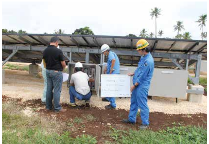
Sato vérifie le câblage des panneaux solaires avec les employés locaux avant une séance d'essais.
