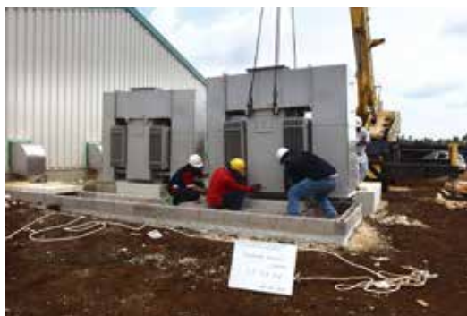
Les employés installent des panneaux qui fonctionnent comme des transformateurs électriques pour alimenter toutes les régions.
