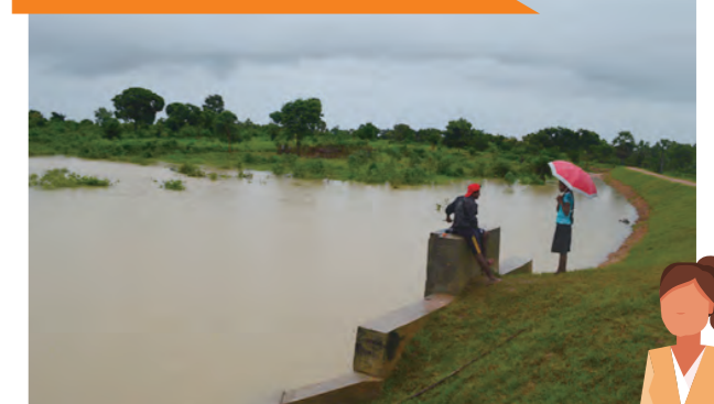
Au Sri Lanka, à la demande de résidentes et avec l'aide des populations locales, Oxfam a construit un réservoir pour prévenir les inondations.
