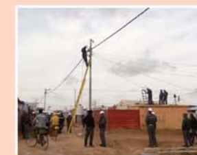
Travaux de câblage au camp de réfugiés de Zaatari.
