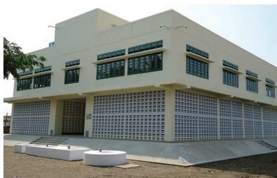
Le rez-de-chaussée est conçu pour que l'eau puisse facilement s'écouler pendant une onde de tempête. La communauté locale peut se réfugier au deuxième étage et sur le toit.
