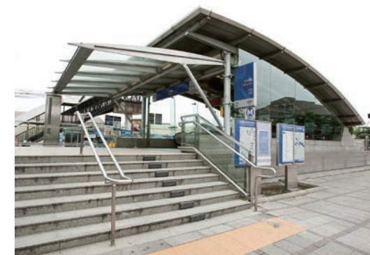
Entrée de la station Bang Sue de la ligne bleue du MRT. L'entrée de la station est surélevée par rapport à la route pour prévenir les inondations.
