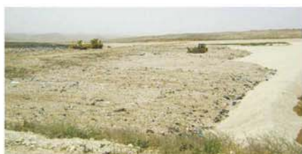
Le site d'élimination des déchets à Hébron, construit avec le soutien de la Banque mondiale, fonctionne presque à pleine capacité. L'extension du site et l'établissement de nouvelles décharges sont urgents.
