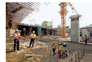
La mise en œuvre de mesures de sécurité sur les chantiers s'est imposée au fil de la réalisation des projets. Ces mesures sont désormais automatiques.
