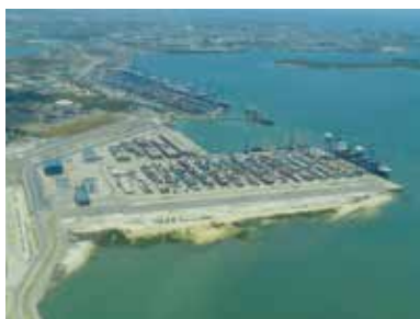
Le nouveau terminal de conteneurs du port de Mombasa (au premier plan).
