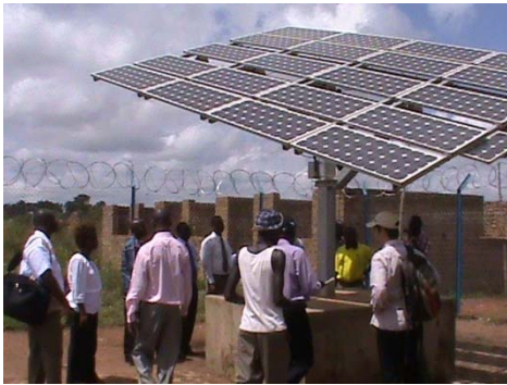
給水ポンプ用太陽光発電パネル (Pabbo プロジェクトサイト)
