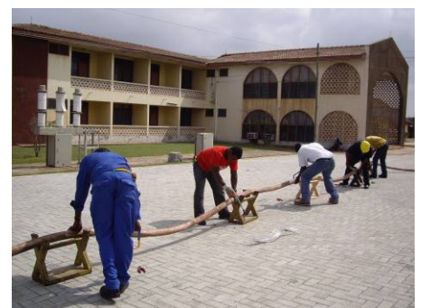
現在実施中のテクニシャン研修(地下ケーブル切断・接続研修の状況)。このような研修が毎年約40名の新人テクニシャンに対して1年間の研修プログラムで実施されている。
