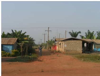
既設配電ルート調査
